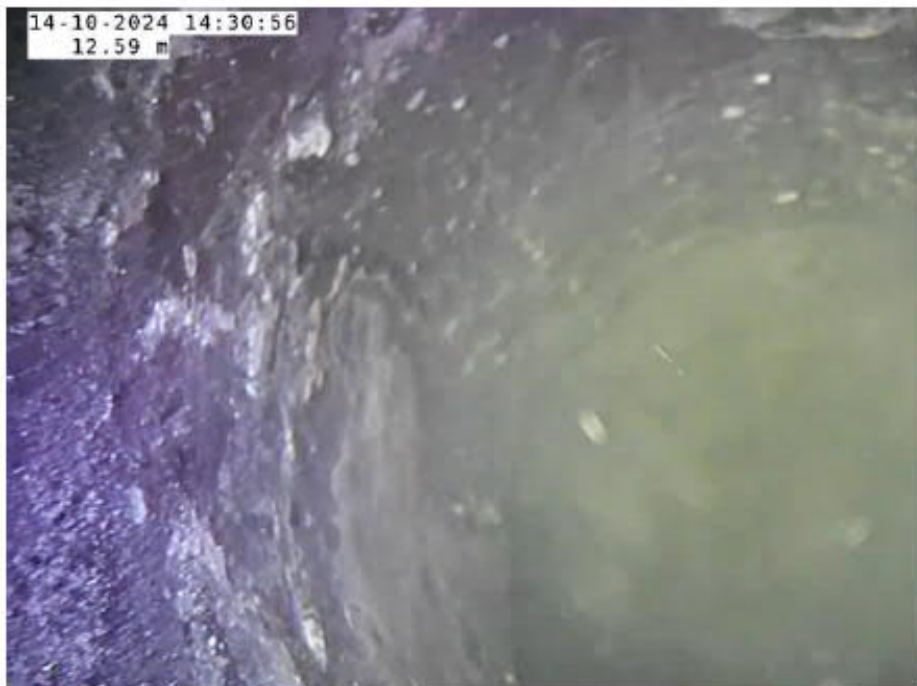
Pohled na betonový přechod na rozhraní kvartér/turon
